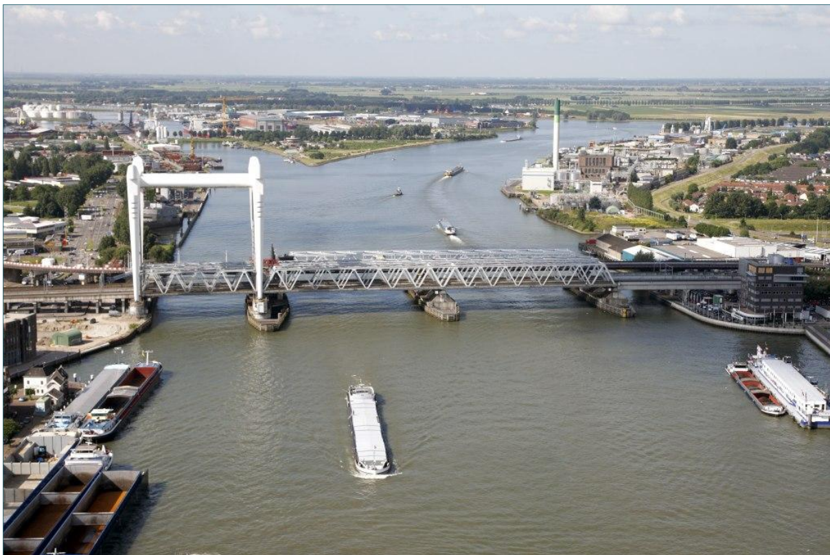
Figure 4-28: Bridge complex ‘Stadsbrug Zwijndrecht’ in Zwijndrecht, the Netherlands 40
